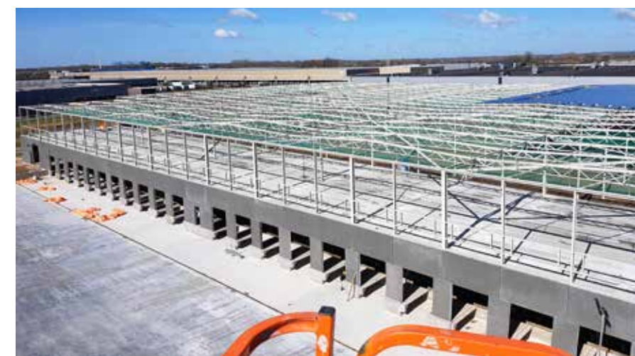
Onderdelen constructie op maat gemaakt in fabriek.
